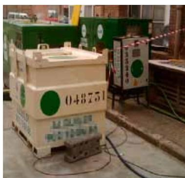
Figura 6. Generador eléctrico de emergencia
